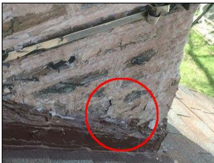
46. Spalling
